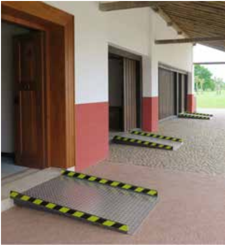
✓ Rampes d'accès mobiles à Xanten, permettant l'accès aux espaces intérieurs. © LVR Parc archéologique de Xanten, S. Engelhard
