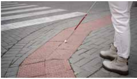
Exemple de marquage podotactile observable à l'étranger. Ce type de marquage doit éveiller l'attention et rendre attentif à un changement dans l'espace. En Suisse, ce type de surface n'est autorisé que pour les rampes d'accès ponctuelles. © Freepik 2025
